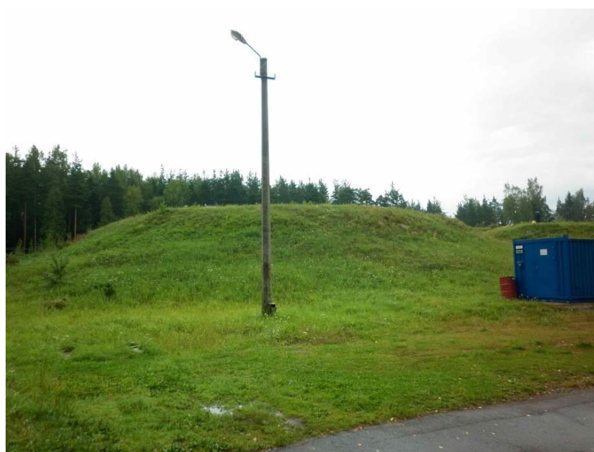
Рисунок 16. Резервуары чистой воды ВНС №1 «Главная»
