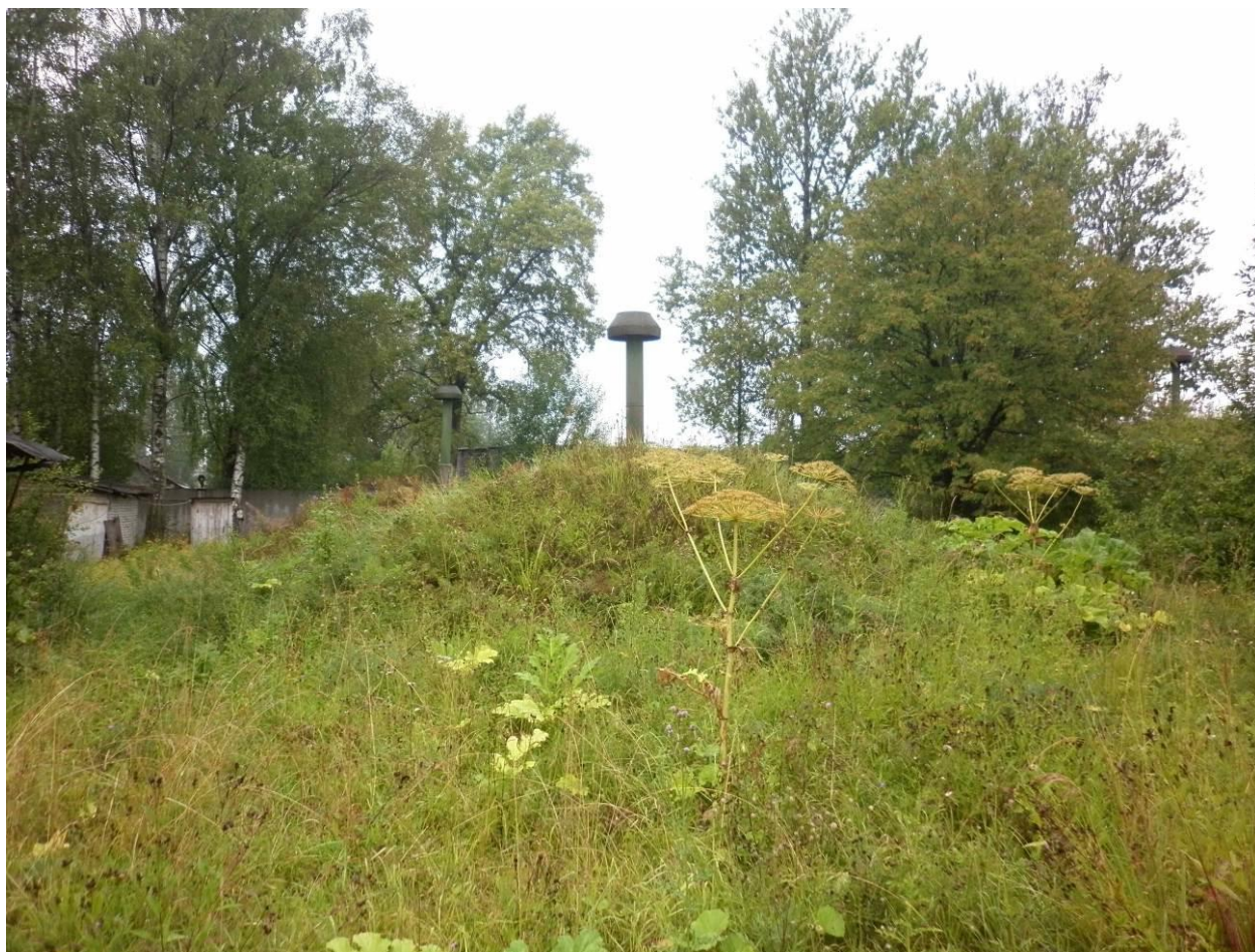
Рисунок 25. Резервуары чистой воды ВНС №1 (мкр. Черная Речка)
