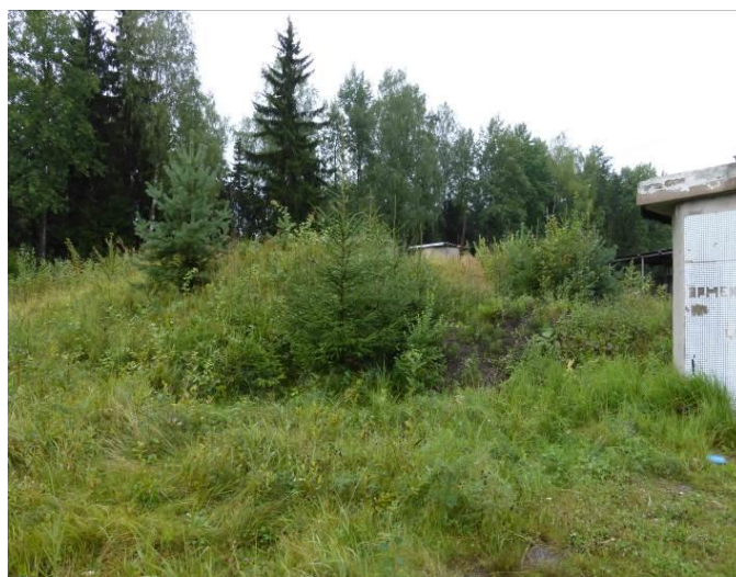
Рисунок 12. Резервуары чистой воды мкр. Сертолово-1, в/г Сертолово-3
