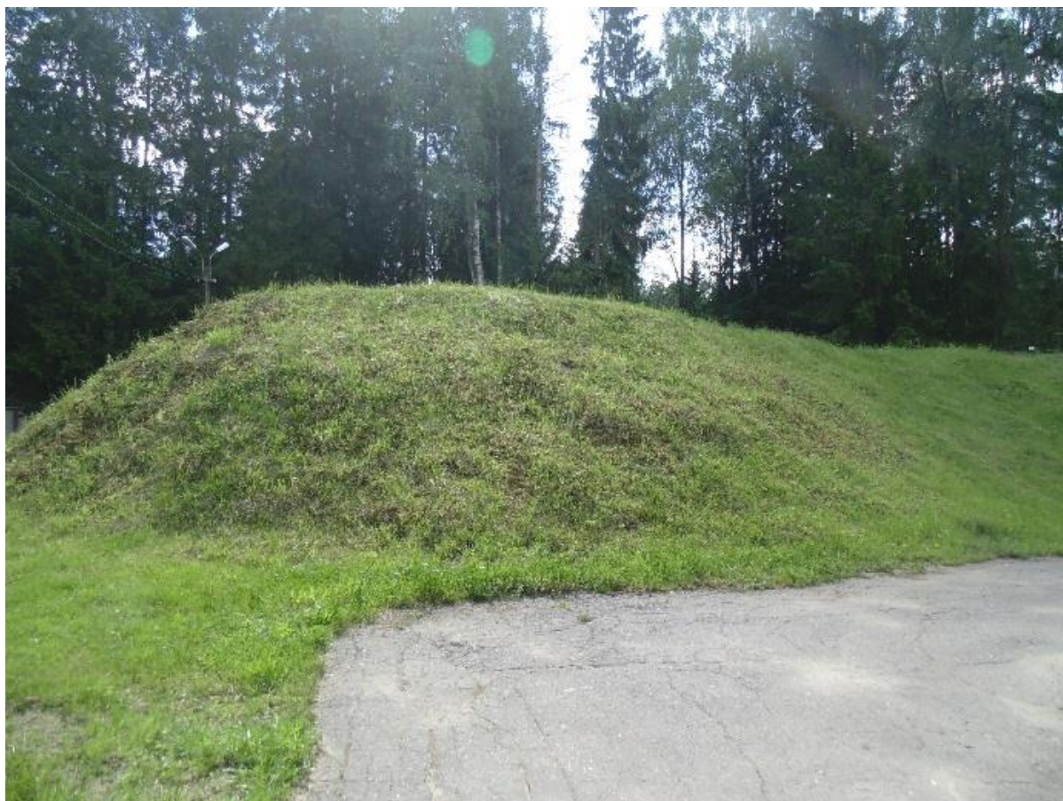
Рисунок 22. Резервуары чистой воды ВНС №8 (мкр. Сертолово-2)
