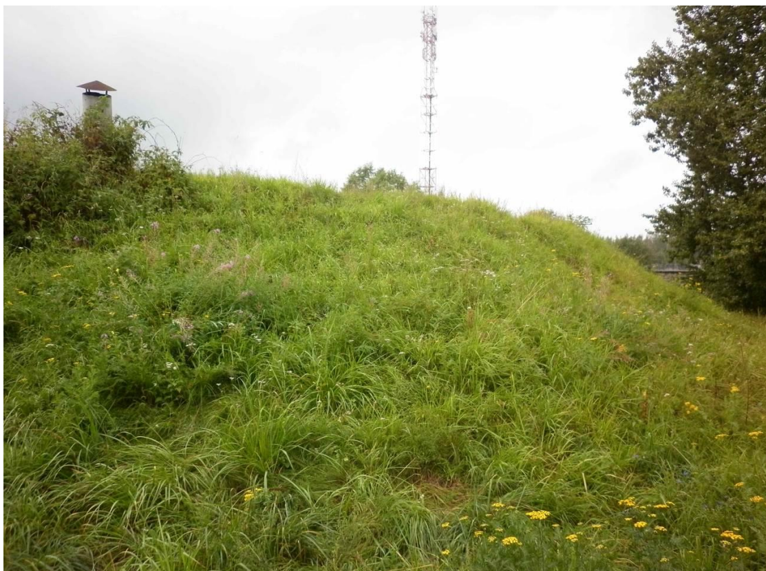
Рисунок 19. Резервуары чистой воды ВНС №2 «Центральная»
